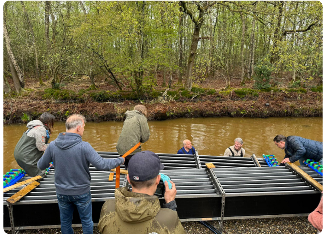
Plaatsing van de warmtewisselaars in een sloot bij een mini-warmtenet in Soest
